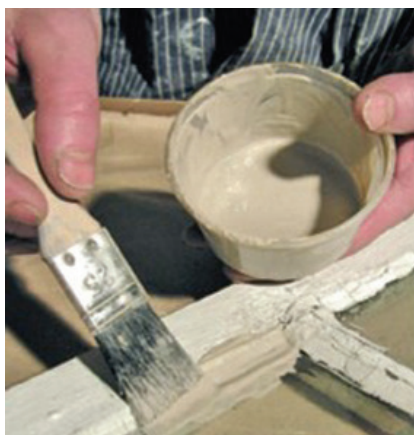
Stopverfpapje, eenvoudige remedie om veroudering tegen te gaan.
