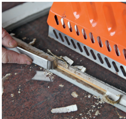
Putty-lamp om stopverf te verwijderen. Tot op zekere hoogte ook te gebruiken voor het verwijderen van verf.
